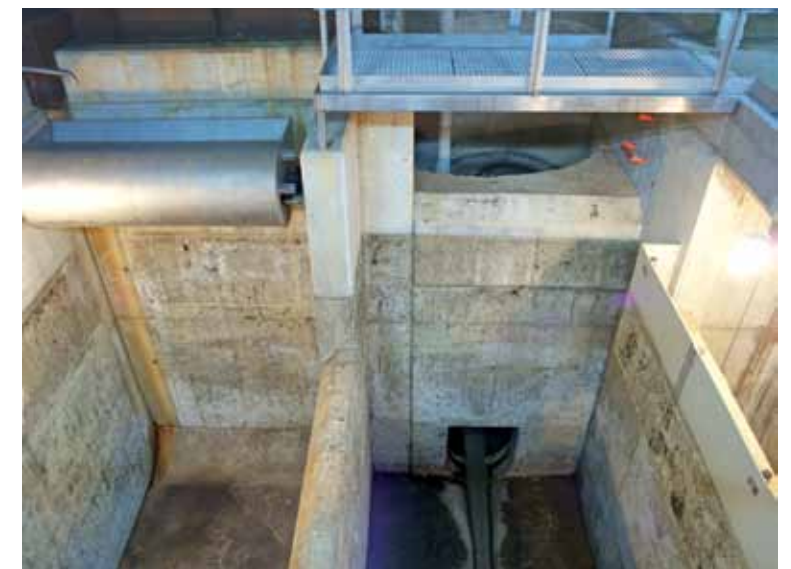
1 Detalle de cámara de entrada e cámara de tormenta con volquete.
